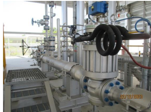
รูปที่ 3-46 ระบบวาล์วสำหรับบริเวณสถานีควบคุม ก๊าซธรรมชาติ
